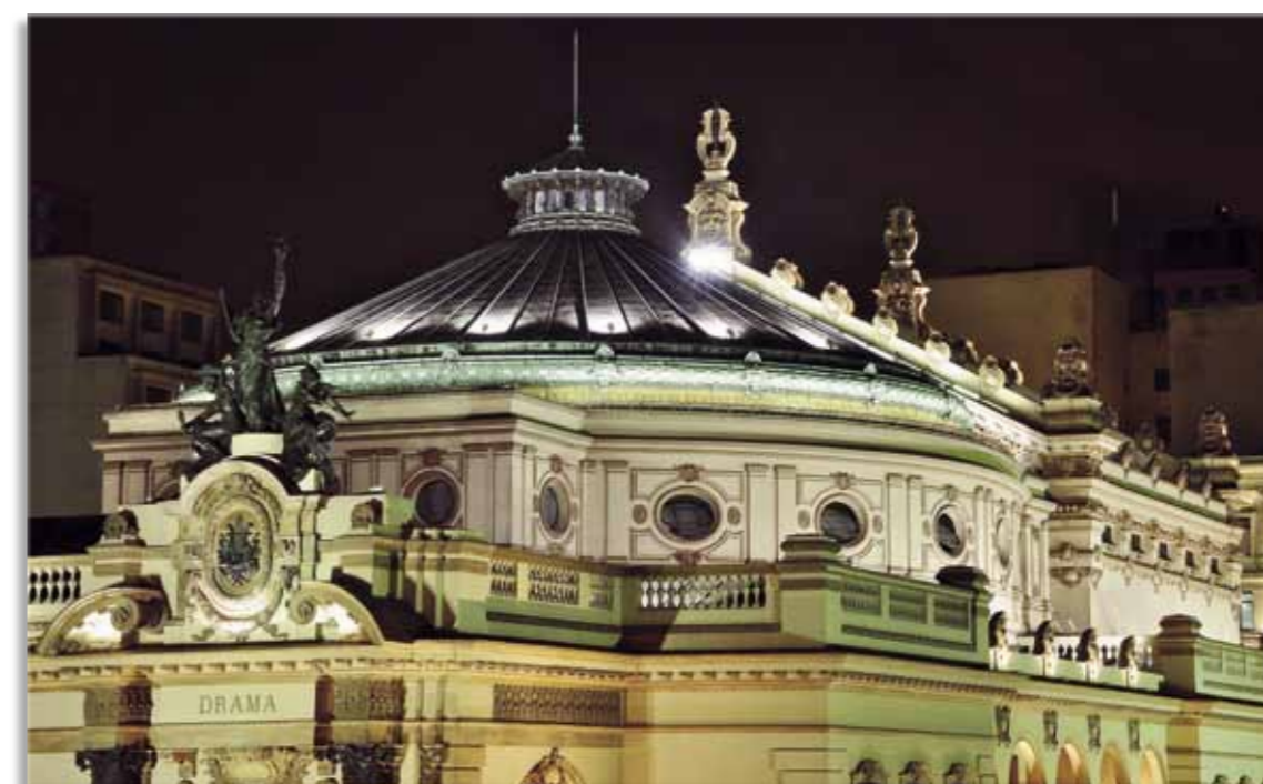
Acima, colunas e atlantes destacados por embutidos no piso com lâmpadas de vapor metálico de 70W a 3000K. À esquerda, cúpula iluminada por 36 metálicas de 150W a 4200K.
